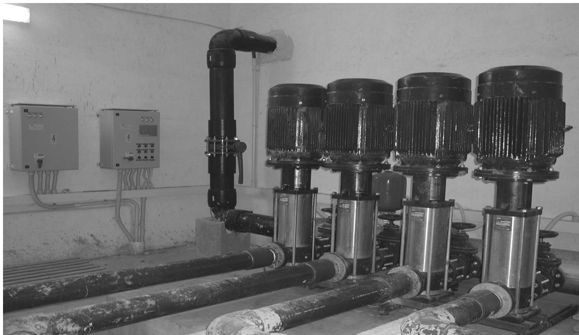
Gruppo idrico a velocità variabile tipo GVE4 KV 90 05 400 (Campo da golf masseria S. Domenico Fasano BR)
